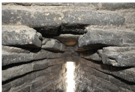
تصویر ۷. الف) چینش آجرها برای ایجاد روزن. ب) نیفتادن بندهای آجر در هر رج (افقی، عمودی). مأخذ: نگارندگان.
