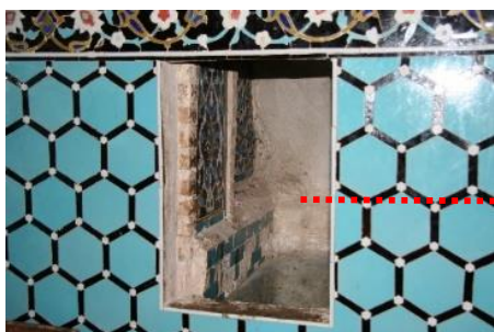
تصویر ۱. آثار باقی‌مانده از تزیینات دوره تیموری که در پروار کردن پایه‌های گنبد در دوران صفویه در لایه‌های زیرین باقی مانده است. مأخذ: نگارندگان.
