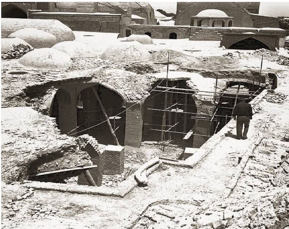
تصویر ۲. مسجد جامع اصفهان در دوره جنگ ایران و عراق. مأخذ: آرشیو دکتر احد نژادابراهیمی.
