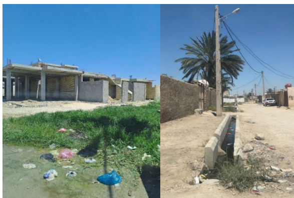
تصویر ۱. محله، ساختمان نیمه کاره بنیاد مسکن، جمع آوری نامناسب زباله، زیر ساخت زیر بنایی و روبنایی نامناسب. عکس: نگارندگان، ۱۴۰۳.
